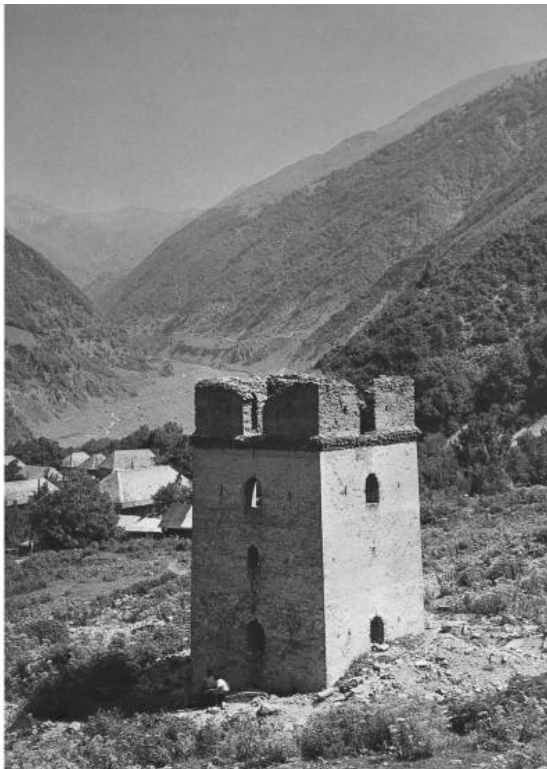
Qax. İlisu kəndində Sumuq - qala qülləsi. XVI əsr
